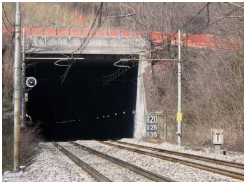
Portale sud della "Monteolimpino 2" – Mar 2011
