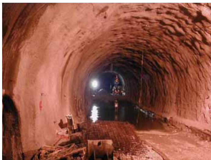
"Monteolimpino 2": opere di consolidamento
