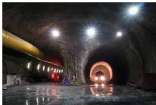
Portale caverna Vigana – cantiere di Camorino
